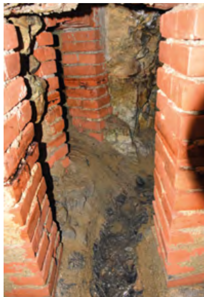
Olomouc, Denisova ulice, chodby podzemního odvodňovacího systému pod kinem Central
