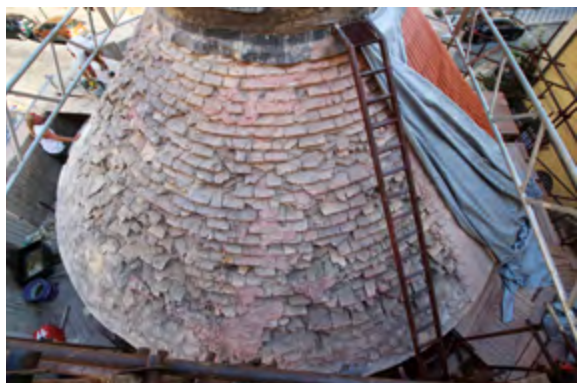
Odhalená románská opuková krytina na střeše lodi rotundy sv. Kříže na Starém Městě byla po zdokumentování a zajištění opět zakryta
