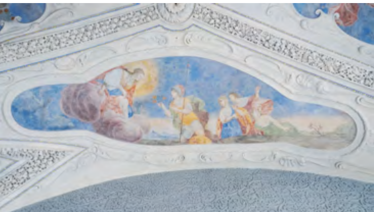
Obnovený strop jídelny, SZ Červená Lhota
