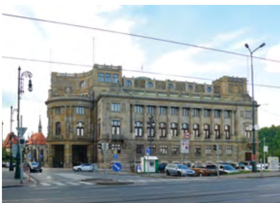
Budova Ministerstva průmyslu a obchodu, čp. 1039, Staré Město
