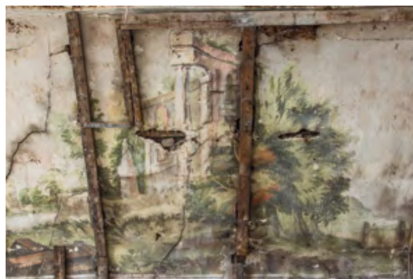
Nález malované výzdoby v podkrovním prostoru v jižním cípu objektu z období klasicismu, západní stěna
