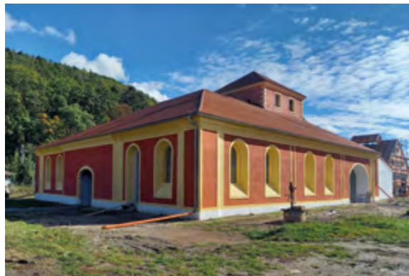
Obnovená fasáda železářské huti Barbora v Jincích
